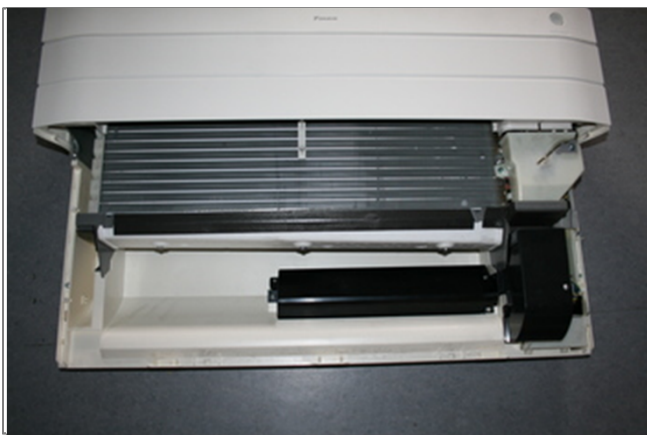
12 Снимите корпус внутреннего блока.
